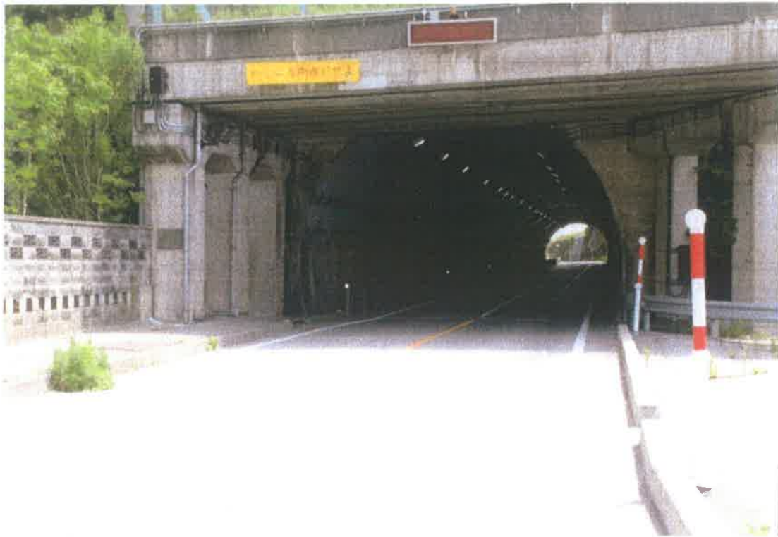
① 国道 160 号線（薮田トンネル入口）
