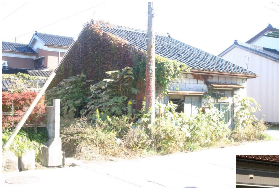
2902-危険老朽化空き家の解体撤去
