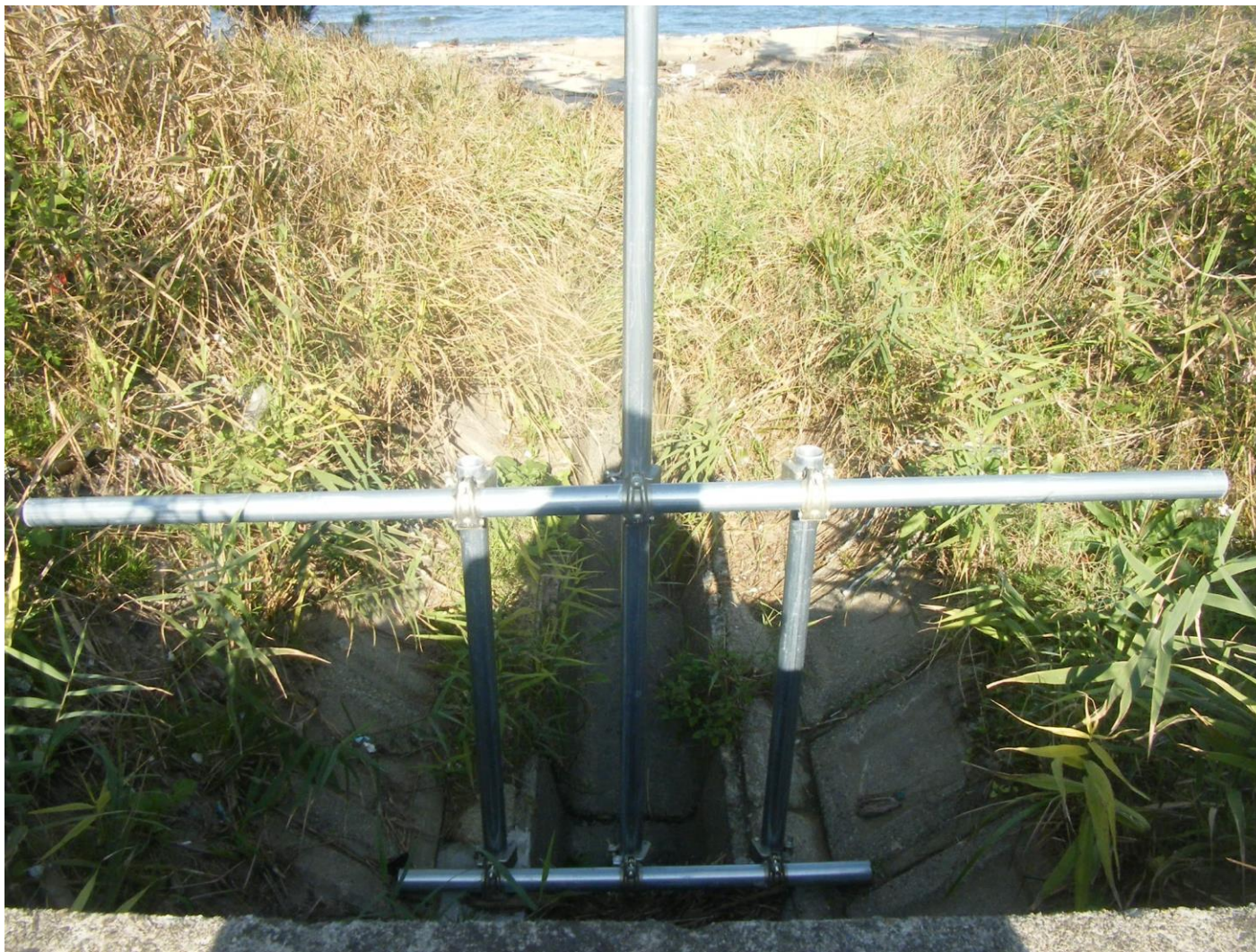
2904/2906-流木流入防止柵設置
