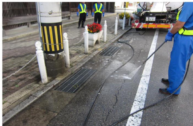
清掃作業状況(業者委託)
