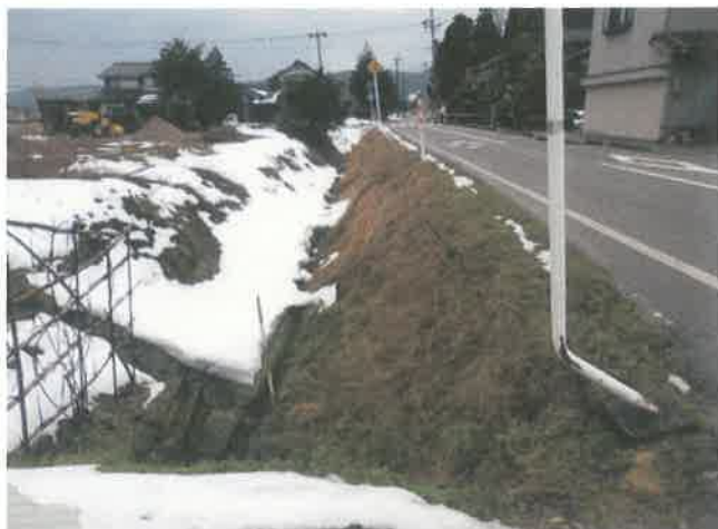
七分一方から柿谷方向を望む(遠景)
