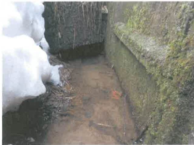
道路側溝上流から暗渠流入口付近(柿谷方より)
