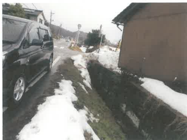
道路側溝上流から暗渠部分を望む(柿谷方より)
