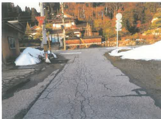
市道泉柿谷線と一般県道柿谷池田線の交差箇所
