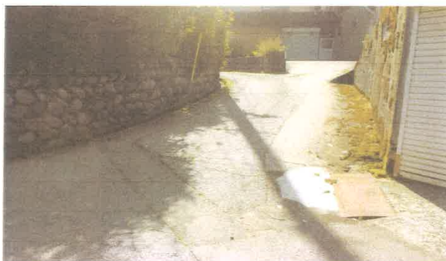
⑦市道論田菅池線路肩。法面下がり水路破損 新
