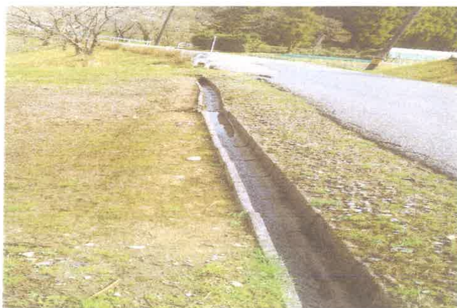
⑦市道論田菅池線路肩。法面下がり水路破損 新
