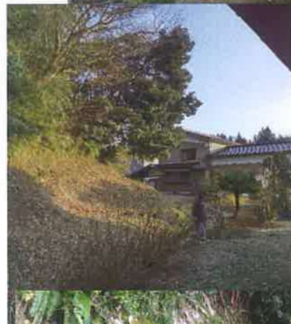
⑦-2地滑り防止工事 (〇〇〇〇邸 裏)
