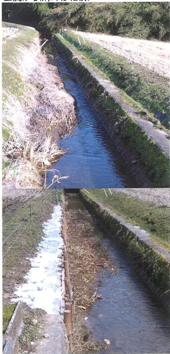
上流から(溝畔修繕前)
