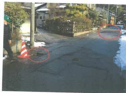
⑩ アスファルト道路陥没
