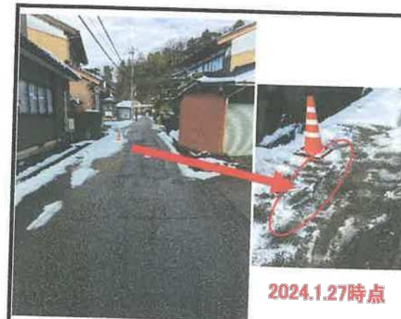
⑪ アスファルト道路陥没
