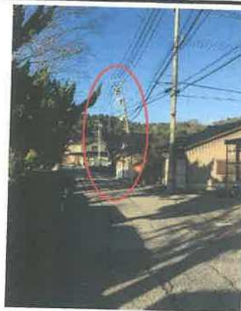
⑦ 電柱傾斜 (北陸電力送配電へ連絡済)
