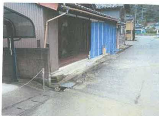
④ 液状化とマンホール隆起
