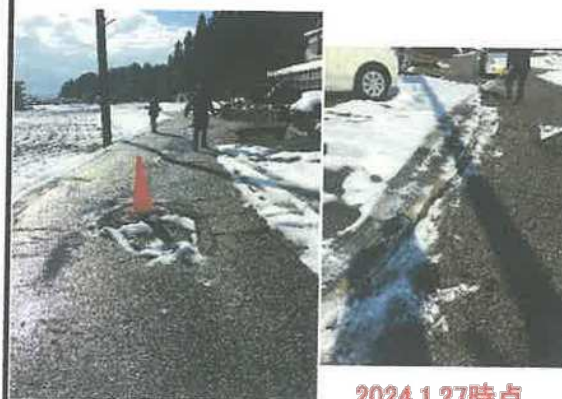
⑳ マンホール隆起 道路陥没(亀裂)
