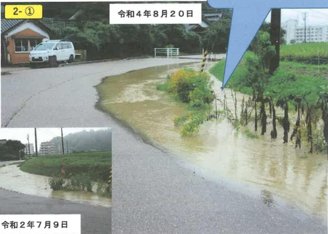
\* 排水路 暗渠部(ヒューム管)で水の流れが悪くなる
