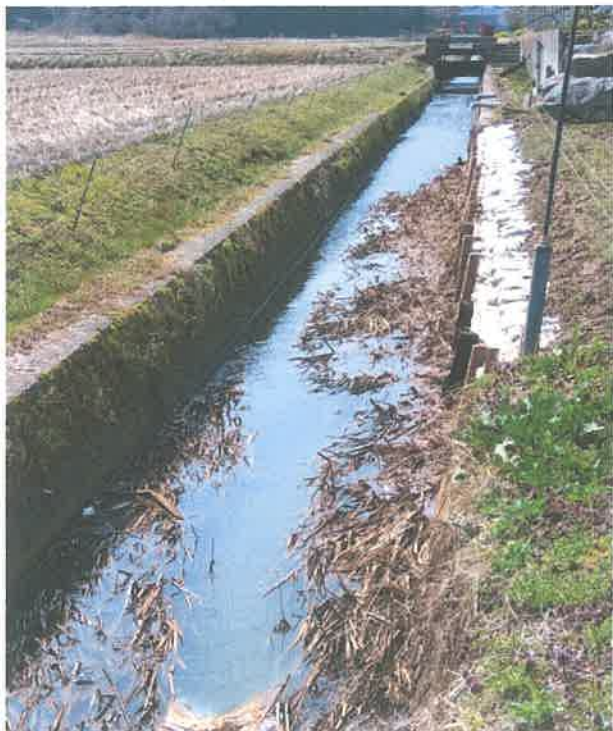
下流から(溝畔修繕後)
