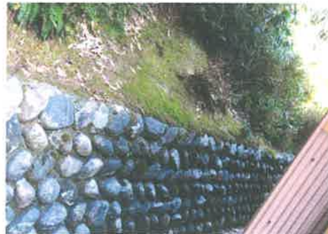
⑦-3地滑り防止工事
