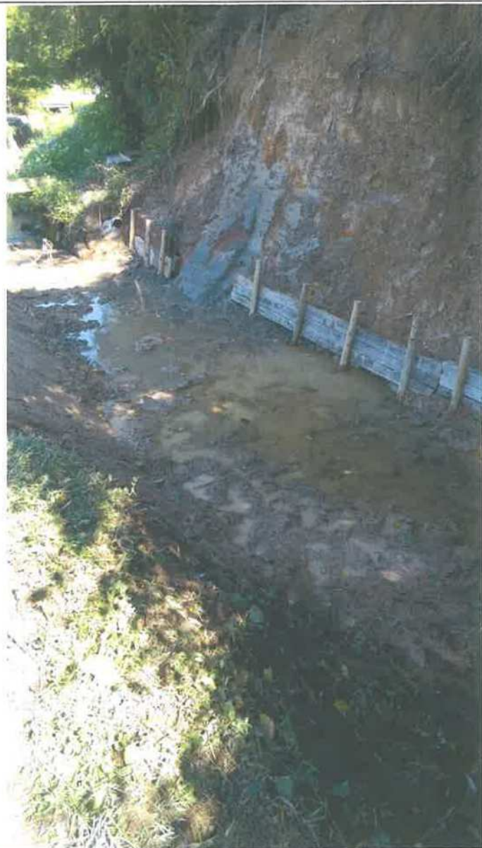
令和 4年 10 月 2 日 撮影 五郎平水門付近の崩壊法面補修後 上流から
