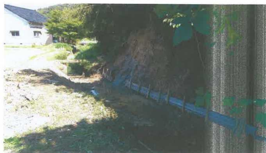
令和 4年 10月 2日 撮影 五郎平水門付近の崩壊法面補修後 上流から
