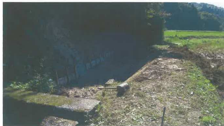
令和 4年 10月 2日 撮影 五郎平水門付近の崩壊法面補修後 下流から
