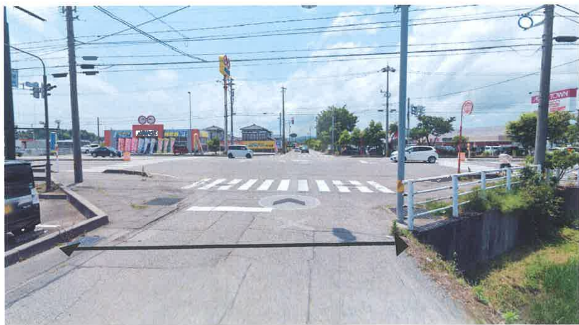
交差点改良 幅員 6 m 交差点部
