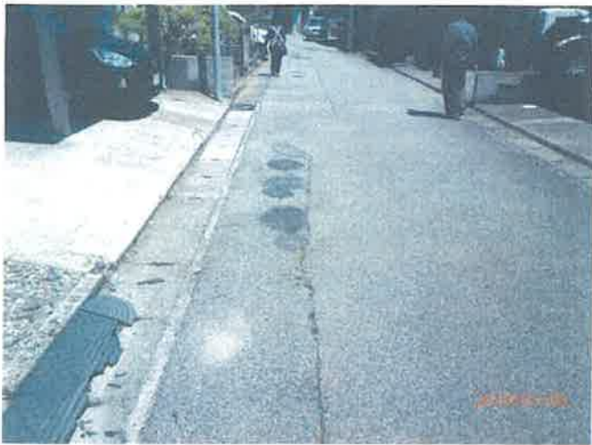
⑤11 和 と の窪みのアスファルト舗装(継続要望)
