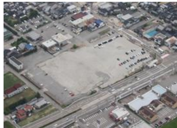
新文化交流施設整備予定地 （旧市民病院跡地）
