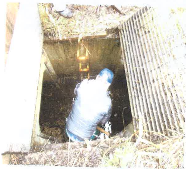
③山側入口に押し戻されたごみを四つ鍬で救い出す作業（相当時間がかかる）
