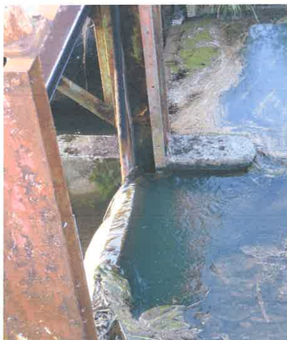
支柱がずれている
