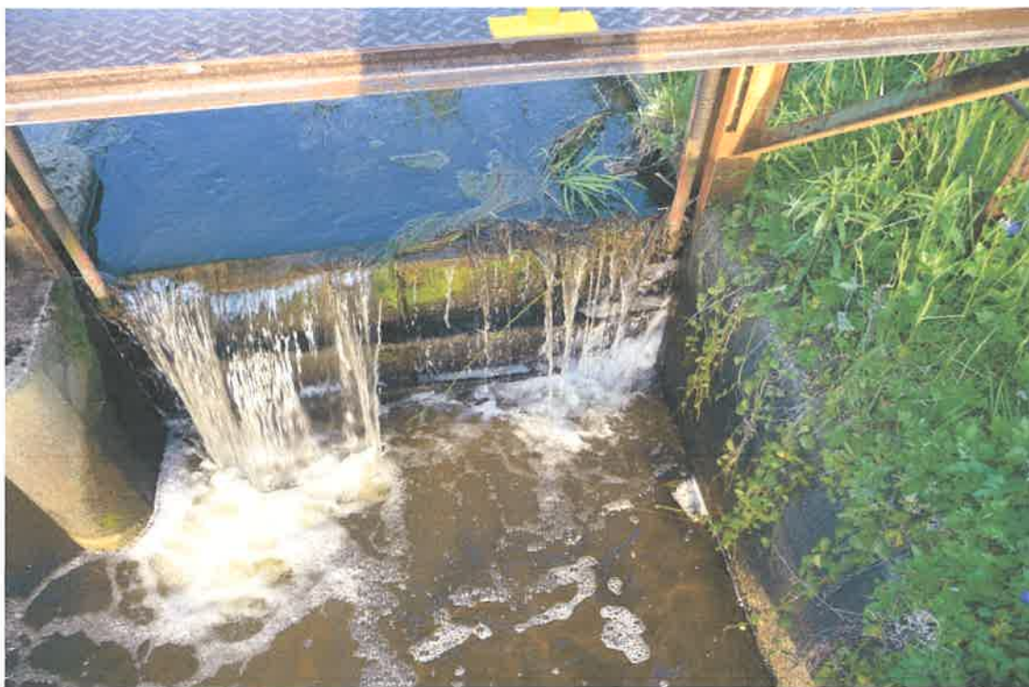
支柱がずれている
