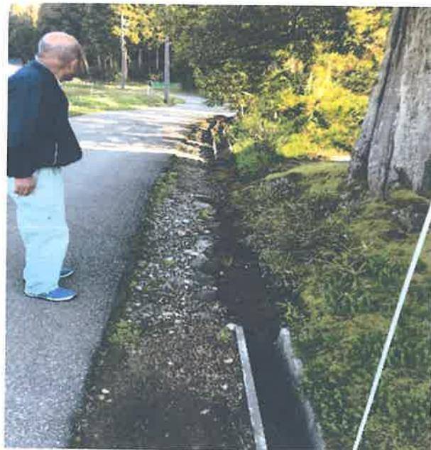
③個人所有の車庫の前面指導が段々沈下して、車の出入りに支障がある。
