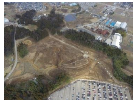
整備中の大浦第2工業団地
