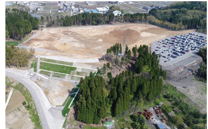
整備中の大浦第2工業団地
