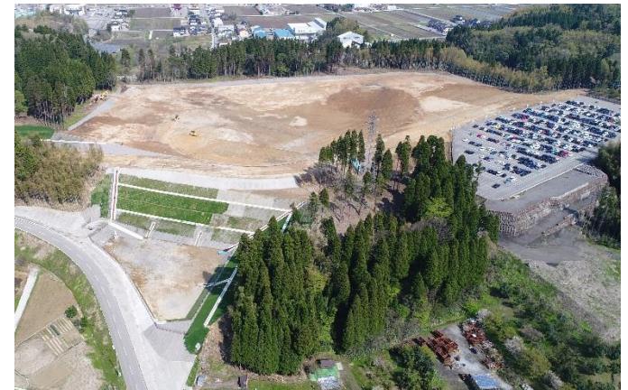
整備中の大浦第2工業団地
