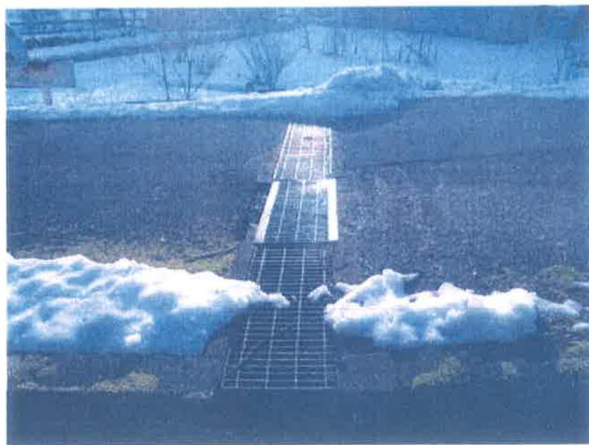
市道触坂古磯線横断側溝の修繕
