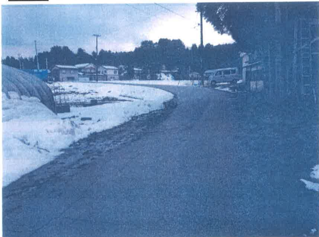
市道触坂野手線拡幅工事 (宅前～県道まで)
