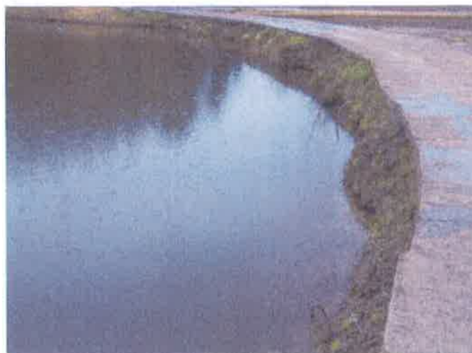
前側法面状況
