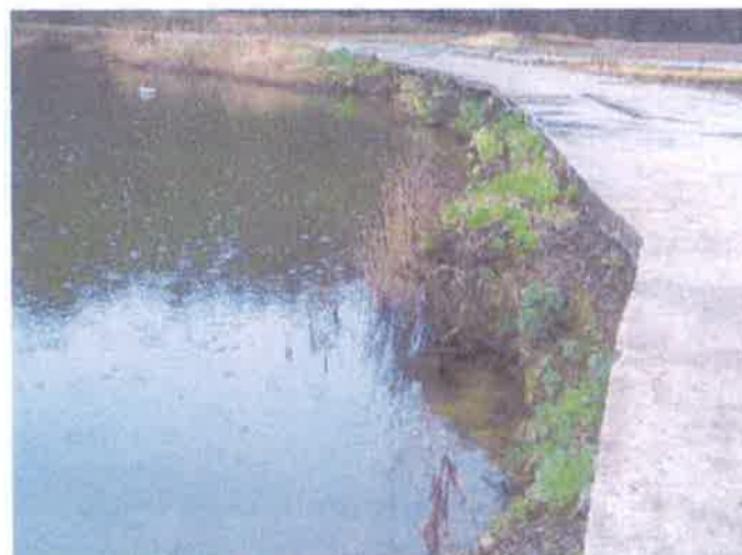
前側法面状況
