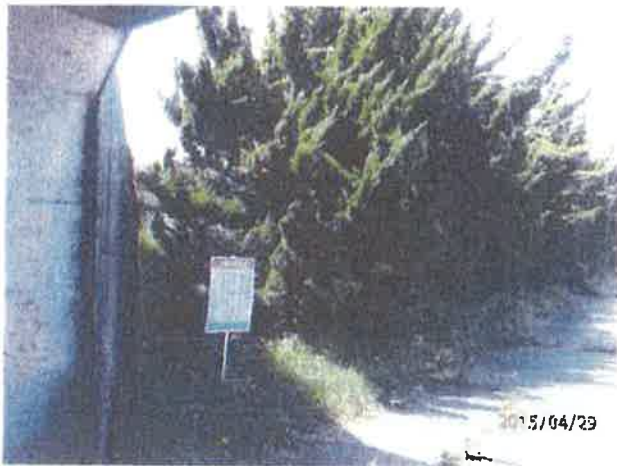
太湖橋隧道東側
