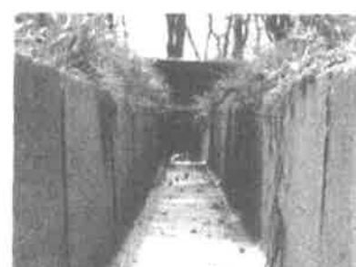
6) 駅側より 6 本目排水路
