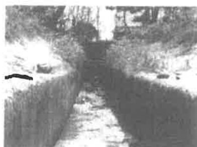
5) 駅側より 5 本目排水路
