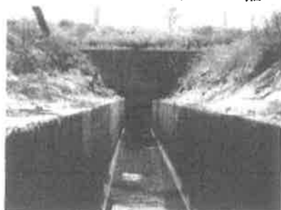
1) 駅側より 1 本目の排水路
