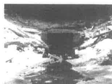
3) 駅側より 3 本目排水路
