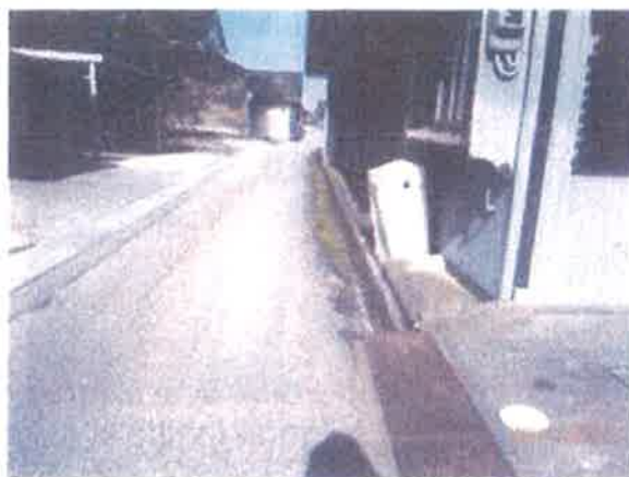
② 対向車両があると側溝に転倒の危険あり。
