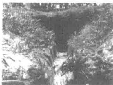
4) 駅側より 4 本目排水路
