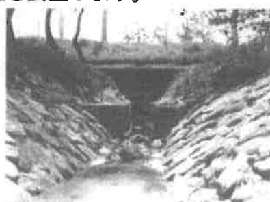
2) 駅側より 2 本目排水路
